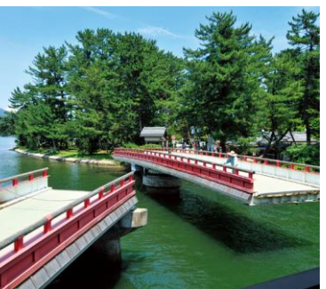
天橋立 船の通り道 廻旋橋
