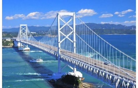
本州~淡路島 明石海峡大橋
